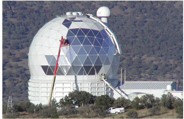
Figure 18. HET "Chrome Dome" project in progress.
